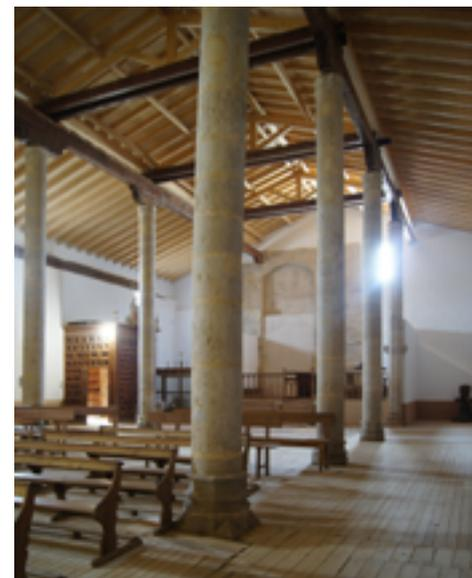
Antes de la intervención el sencillo techo de yeso situado sobre las naves tapaba una precaria estructura de madera en la que aún se conservaban elementos del artesanado que originalmente las cubrió. Entre las columnas de piedra se habían construido unos falsos arcos, también de yeso. Con la obra se eliminaron estos elementos, apareciendo interesantes piezas de madera labrada, especialmente los *zapatonos* roleados.
