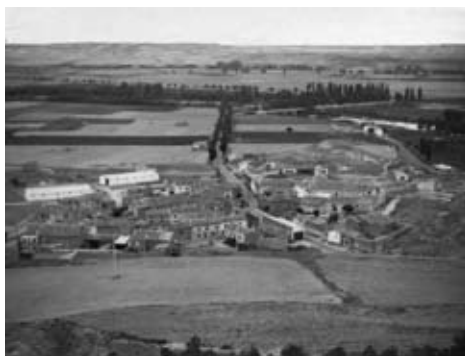
Vista general de Reinoso antiguo.
