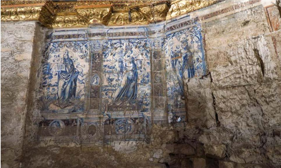
Aspecto de la azulejería tras la retirada del zócalo de madera. A la izquierda la pilastra de ladrillo que ocultaba parte del panel.
