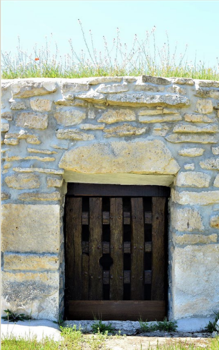
Puerta de acceso de una bodega.
