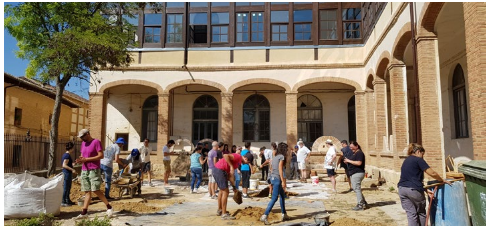
Antiguas escuelas en rehabilitación.
