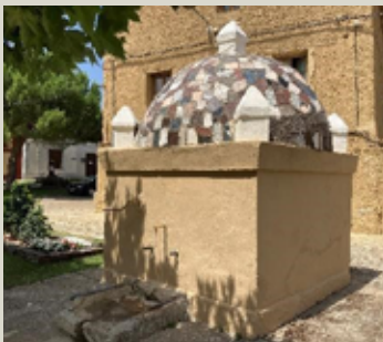
Fuente de la plaza con mecanismo de bombeo recuperado.
