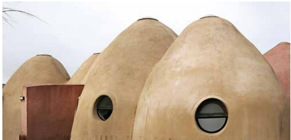
Vista Acabado exterior de las Cúpulas.
