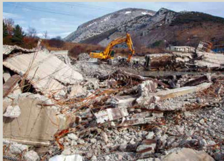
Restos de la demolición del refrigerante.
