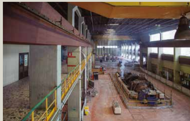
Desmantelamiento de la sala de turbinas.
