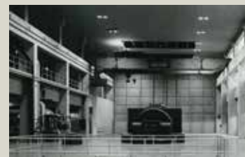
Vista interior de la sala de turbinas del grupo I la central térmica de Velilla. 1964.
