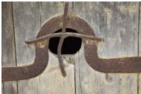
Puerta Bodega de Dueñas. Detalle ventilación.
