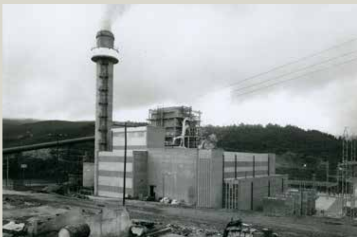
Vista exterior de la construcción del grupo I la central térmica de Velilla. 1964.
