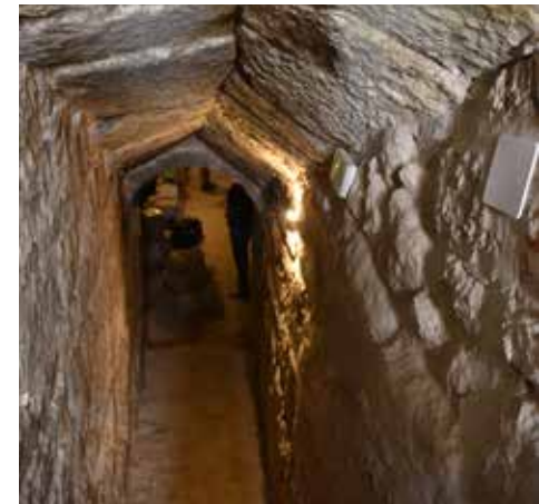
Acceso de bajada a la bodega, con lajas de piedra.
